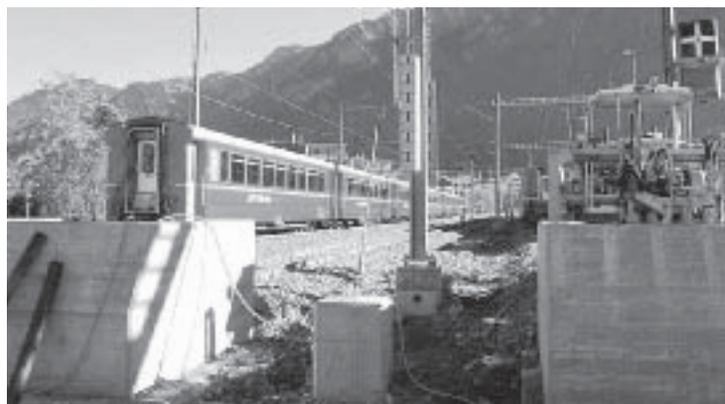
und längere Gleise für das Abstellen von Wagengruppen und ganzen Zugkompositionen zur Verfügung. Dafür wurden rund 2700 m Gleis und 18 Weichen neu verlegt und 3200 t Schotter eingebaut. Gleichzeitig wurden die Fahrleitungsanlagen komplett erneuert, eine neue Zugvorheizanlage und eine neue Gleisbeleuchtung installiert und x-hundert Meter Kabelkanalisationen und Rohrleitungen verlegt.
